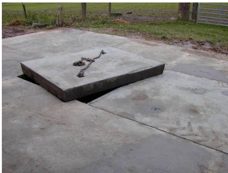
Fig. 18 & 19: Voorbeelden van buffertanken. Links: een buffertank van 4000 l boven de grond. Rechts: een buffertank van 5000 l onder de grond met een afzonderlijke klep voor regenwater (Bron: pcfruit vzw).
