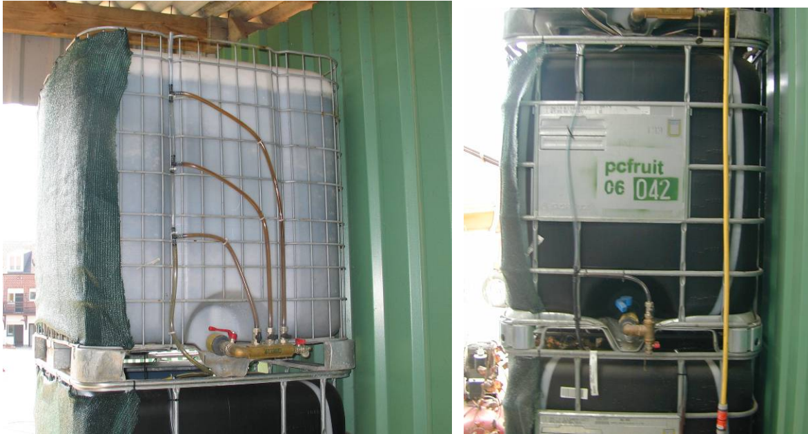
Fig. 35 en 36: Om een optimale vochtigheidsgraad te bekomen in de 2 bovenste units van de biofilter, wordt een verzadigde zone behouden op de bodem van de unit zodat het water door capillaire krachten kan stijgen. Dit kan bekomen worden door de afvoer van de unit te koppelen aan een leiding die naar boven wordt gebogen en die bovenaan in contact staat met de lucht en aan het andere uiteinde in contact met de volgende unit. De hoogte van de verzadigde zone wordt dan bepaald door de hoogte van de naar boven gebogen leiding. Men kan verschillende hoogtes creëren (links) of een verzadigde zone op 300 liter zoals op de rechter figuur weergegeven (Bron: pcfruit).
