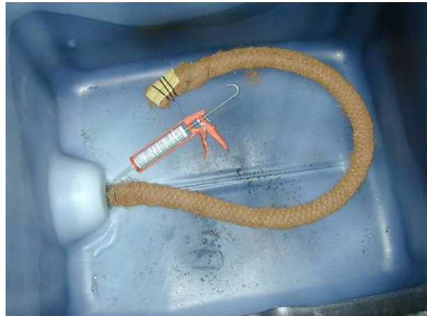
Fig 27: Drainage buizen op de bodem van de biofilter unit (Bron: pcfruit).
