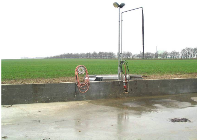
Fig. 15: Afzonderlijke vul- en spoelplaats in beton met een afvoer voor gecontamineerde vloeistoffen naar het biozuiveringssysteem (Bron:DAAS) .
