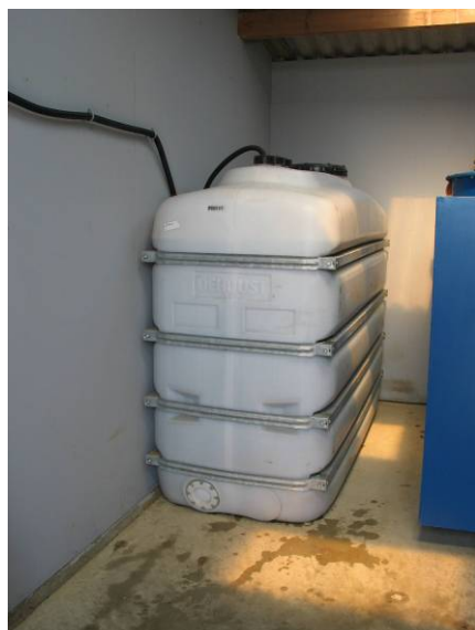
Fig. 18 & 19: Voorbeelden van buffertanken. Links: een buffertank van 4000 l boven de grond. Rechts: een buffertank van 5000 l onder de grond met een afzonderlijke klep voor regenwater (Bron: pcfruit vzw).
